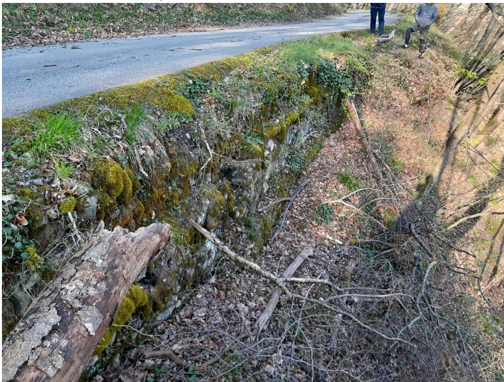
Figure 3 : Ouvrage existant en gabions à reprendre
