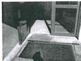
La présence d'un tapis devant la porte n'est pas compatible avec les normes accessibilité. De plus, le contour du tapis doit être ragréé. Les zones de retournement devant et derrière la porte sont conformes.
