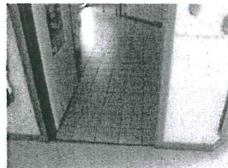
Dans le sanitaire aménagé, la zone de retournement est conforme. Il est nécessaire d'ajouter la barre d'appui et de déplacer le dévidoir papier.
