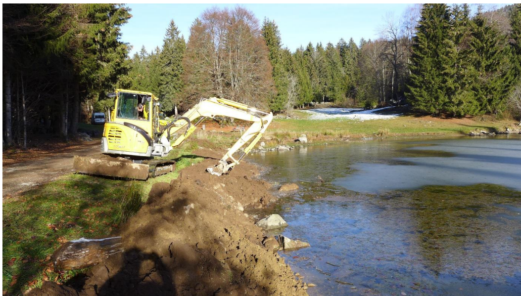
Photo 17: Réaménagement des berges ouest du lac. Travaux réalisés en 2018 (CEN Isère).
